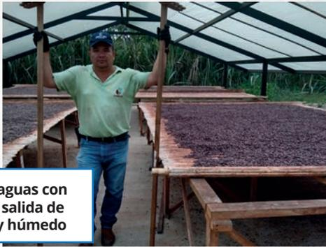
Techos a dos aguas con traslape para salida de aire caliente y húmedo
